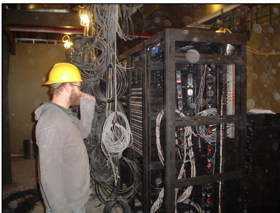
Installing AV Equipment
