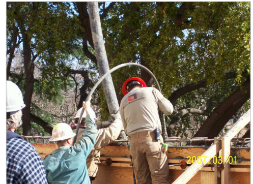
Pouring Parapet Extensions
