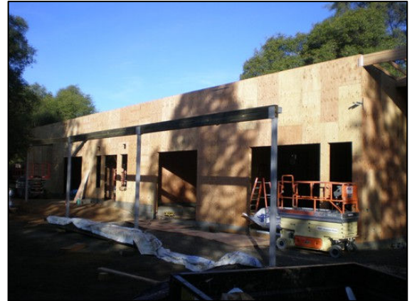
Framing exterior canopies
