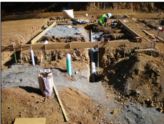
Installing Underground Conduit
