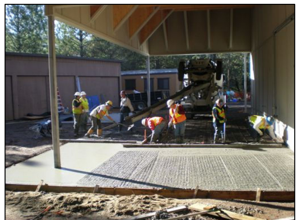
Pouring Site Concrete
